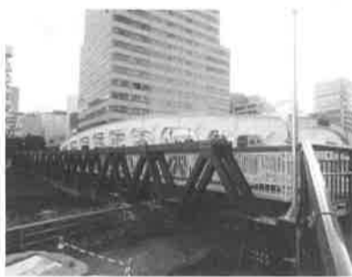
工事中の 豊橋
