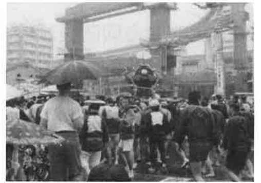
昭和50年代初めの連合渡御の様子 首都高深川線は建設途中
