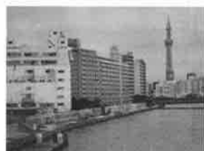
工事中の隅田川堤防(カミソリ堤防)
